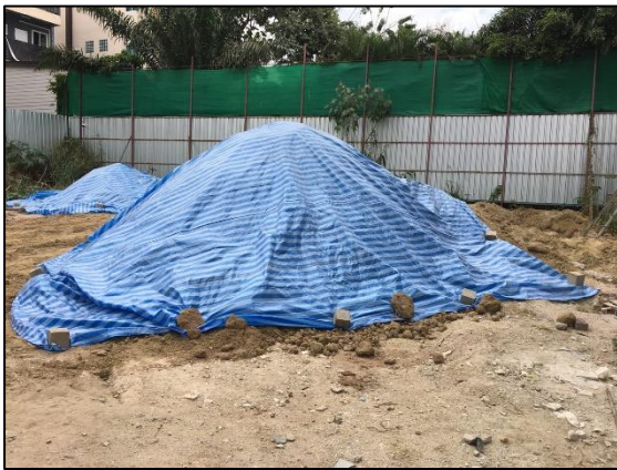
รูปที่ 2-4 ผ้าใบปิดคลุมกองวัสดุก่อสร้าง
